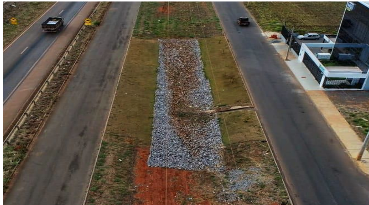
Imagem 04 – Trincheira de infiltração Realizada na Av. Marginal, próximo ao Residencial Cerejeiras
